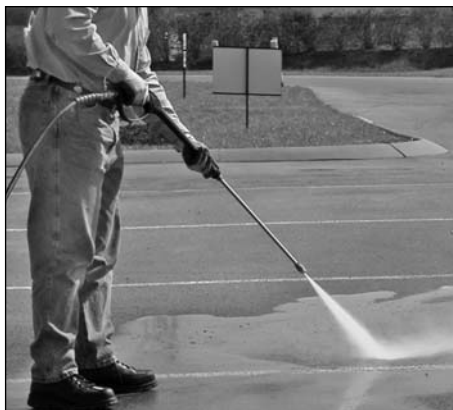
Figura 12 - Mejor ángulo de limpieza de superficies
